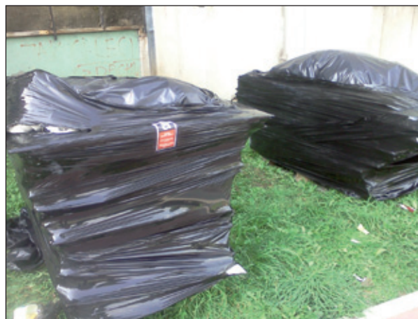
Zdemontowane i zabezpieczone płyty azbestowe
