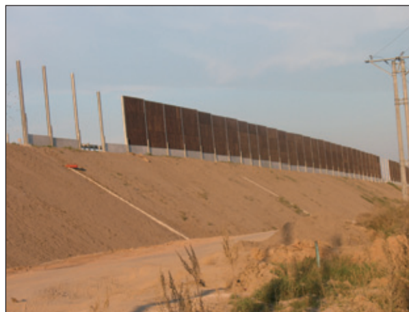
Budowa ekranów akustycznych
