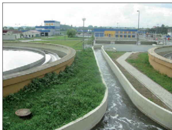
Oczyszczalnia Ścieków Komunalnych w Sitkówce Nowinach
