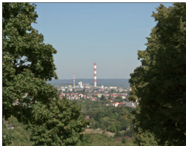
Kominy Elektrociepłowni Kielce
