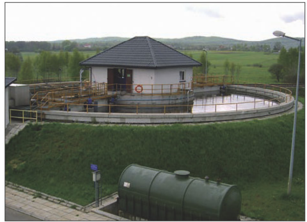
Oczyszczalnia Ścieków Komunalnych w Piekoszowie
