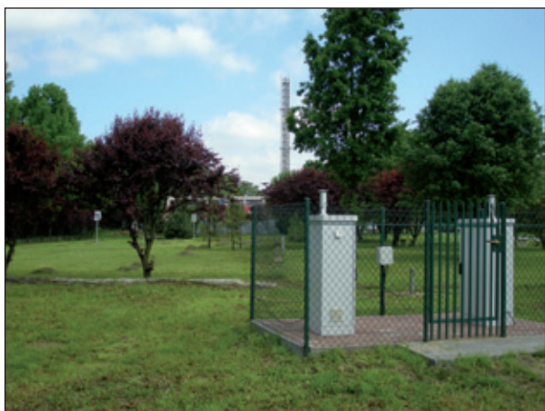
Stacja monitoringu powietrza i ciepłownia gazowa w uzdrowisku Busko Zdrój
