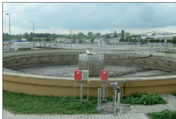
Oczyszczalnia Ścieków Komunalnych w Sitkówce Nowinach
